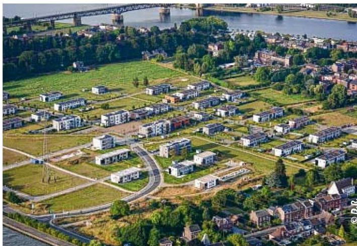
Coincé entre le canal Albert et la Meuse, l'éco-quartier des Pléiades propose pour l'heure 150 nouveaux logements, tous déjà occupés. A terme, le site en comptera 270.
